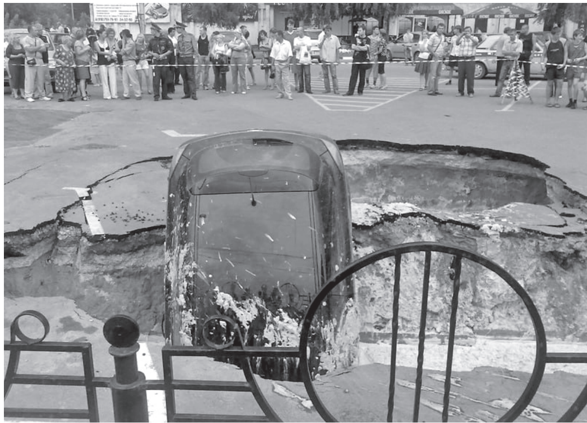
Провал на парковке около центрального универмага
