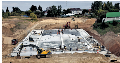
Работы уже идут
