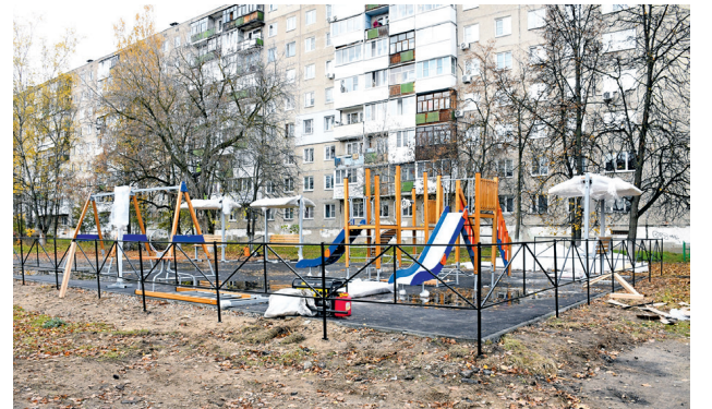
Новая детская площадка на проспекте Циолковского
