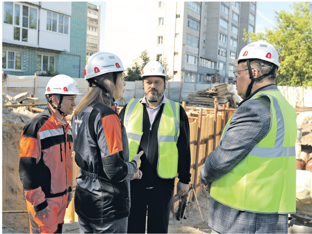
На улице Попова ведется реконструкция павильона магистральных теплотрасс
