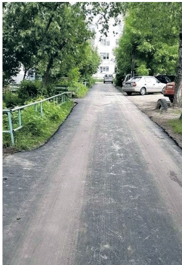
Асфальт проложен по программе ФКГС на улице Маяковского, 43Б
