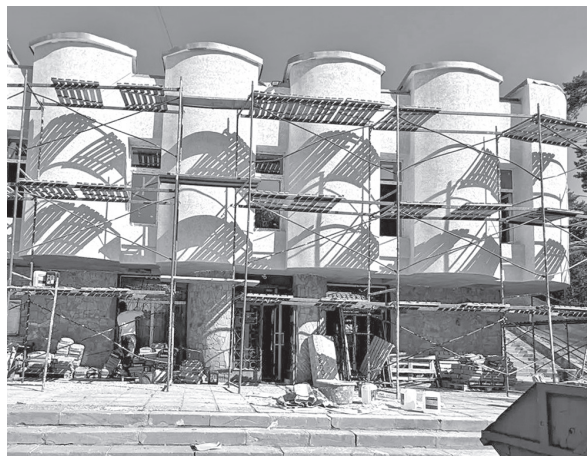
Ремонт Дзержинского театра кукол продолжается
