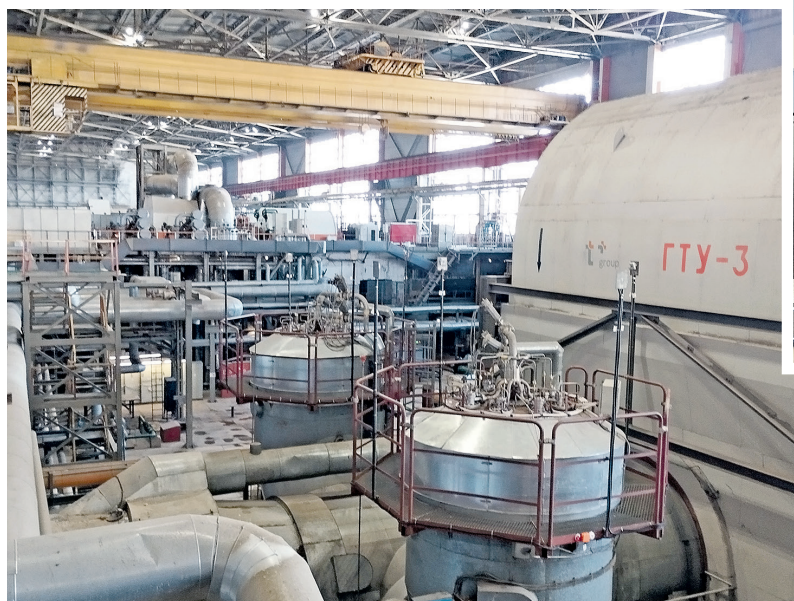
Парогазовую установку в котлотурбинном цехе построили на месте старого демонтированного оборудования
